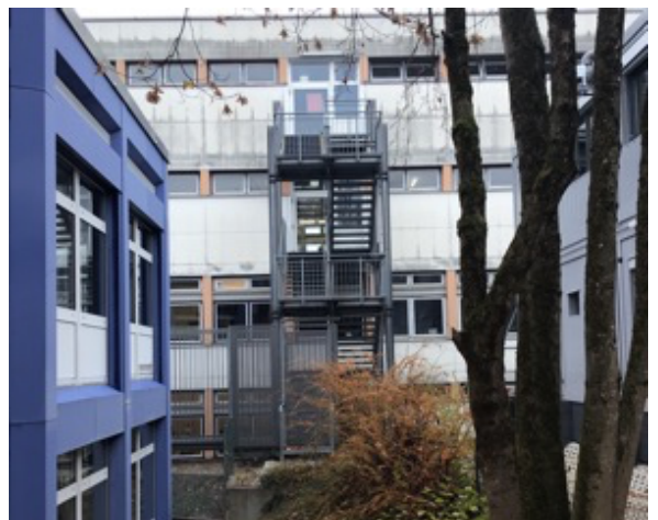
Nördlicher Gebäudeteil der Mittelschule mit Anbau
