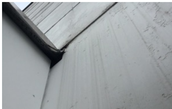
Loch in Fassade des nördlichen Gebäudeteils der Mittelschule
