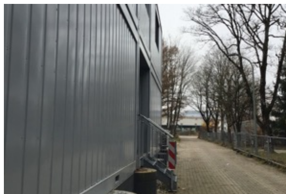
Container im Norden des Planungsgebiets, Blickrichtung Westen
