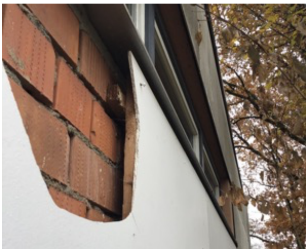
Großes Loch in Außenverkleidung an einstöckigem Gebäudeteil im Norden des Planungsgebiets
