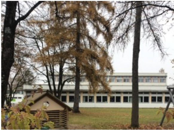
Südlicher Gebäudeteil der Mittelschule, Blick vom Lindenring in Richtung Norden
