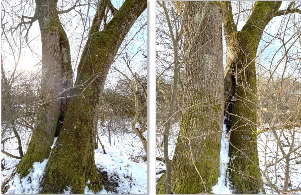
Abb. 78 Baum 31, 724694 – Schaden im Vergabelungsbereich
