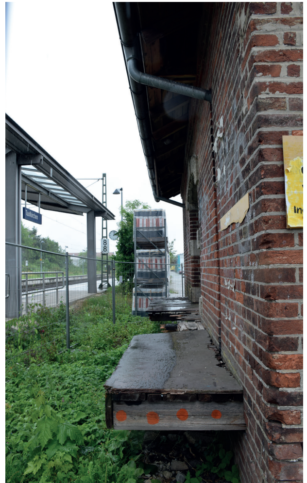
Abb. 31: Nebengebäude 2 - Bahnseite mit Laderampen
